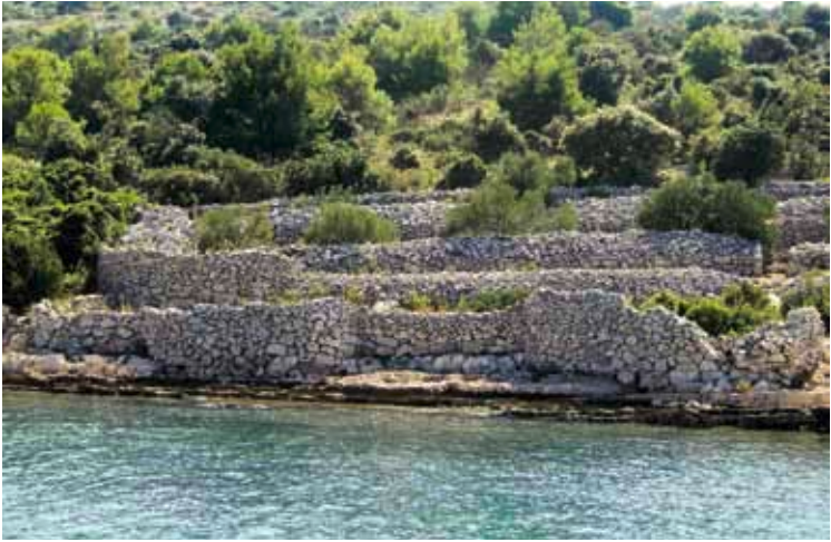
In mühsamer Handarbeit wurden die langen Steinmauern aufgeschichtet.
