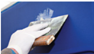
Fill using blade
